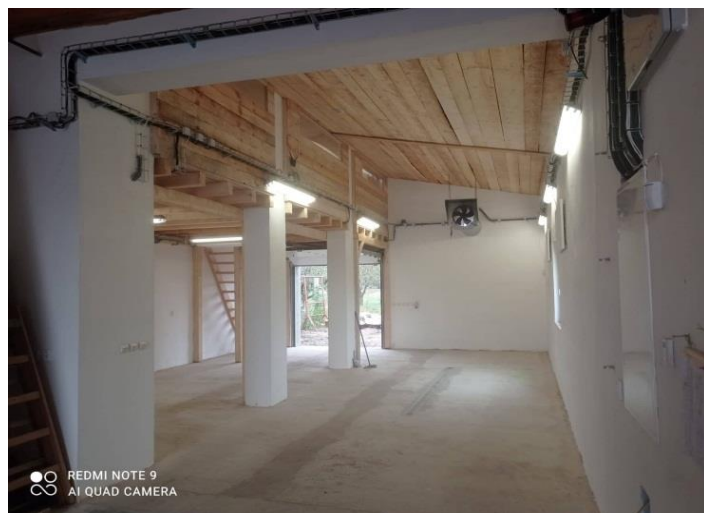
Pohled do nové garáže, ze starší části
