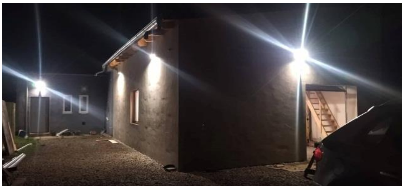
Přístavba hasičské zbrojnice, pohled za hasičárnu
